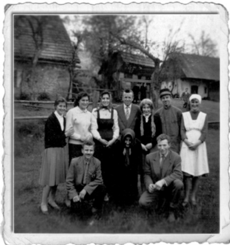
Fotografija gledališke skupine zagraških gasilcev po predstavi Živ pokopan leta 1960. Na skrajni desni strani fotografije je viden del gospodarskega poslopja (zidana kašča), ki so ga ponoči 11. novembra 1945 po ukazu pripadnikov UDBE požgali. Zgradba se je desno nadaljevala še več kot toliko, kolikor se je vidi na fotografiji. Ta del je bil zgrajen iz lesa, razen kamnitih temeljev, na katerih so stali stebri lesene zgradbe.
