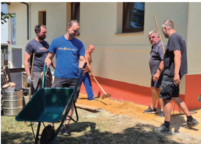
Na severnem delu gasilske garaže je bilo zaradi poškodbe na zunanjem zidu treba obnoviti tudi hidroizolacijo. Ob obnovi temeljev je bilo treba najprej umakniti pohodne plošče, po končanih delih pa so jih domači člani ponovno položili.
