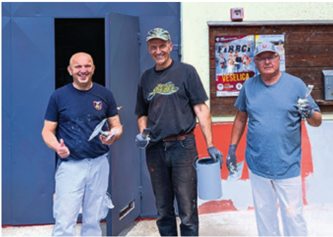
Trenutek za fotografijo domačih pleskarjev, ki so prebarvali cokol in kovinska vrata, pa tudi kurilnico in garažo.
