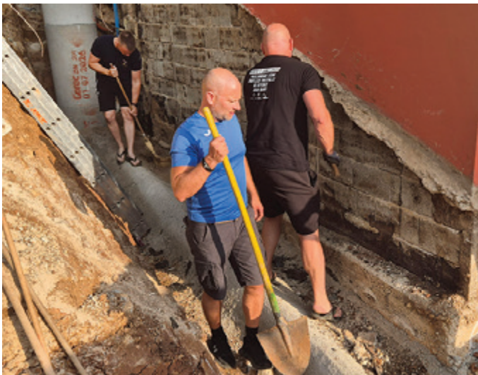
Na severnem delu gasilske garaže je bilo zaradi poškodbe na zunanjem zidu treba obnoviti tudi hidroizolacijo. Ob obnovi temeljev je bilo treba najprej umakniti pohodne plošče, po končanih delih pa so jih domači člani ponovno položili.
