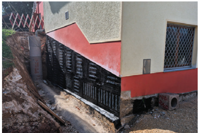
Na severnem delu gasilske garaže je bilo zaradi poškodbe na zunanjem zidu treba obnoviti tudi hidroizolacijo. Ob obnovi temeljev je bilo treba najprej umakniti pohodne plošče, po končanih delih pa so jih domači člani ponovno položili.
