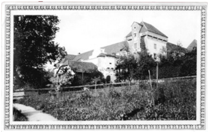
Grad Boštanj z zahodne strani s pogledom proti vhodu in baronovemu stolpu.
