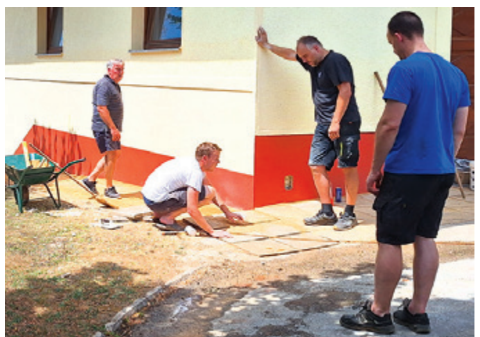
Na severnem delu gasilske garaže je bilo zaradi poškodbe na zunanjem zidu treba obnoviti tudi hidroizolacijo. Ob obnovi temeljev je bilo treba najprej umakniti pohodne plošče, po končanih delih pa so jih domači člani ponovno položili.
