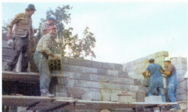
Gradnja novega gasilskega doma, 1987.
