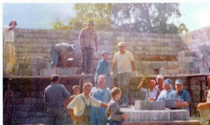
Gradnja novega gasilskega doma, 1987.
