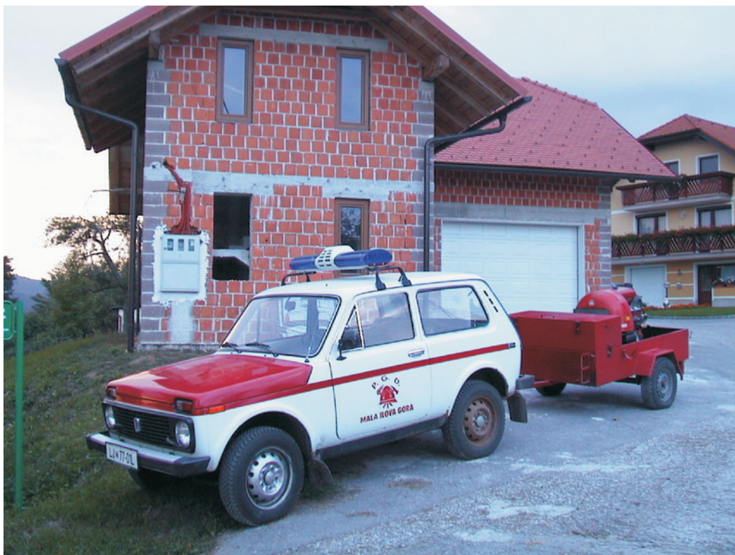
Gasilski dom v gradnji, ter vozilo z brizgalno in opremo
