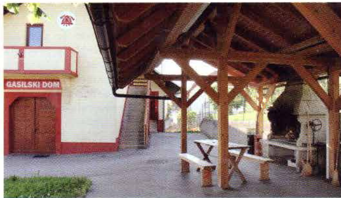
2012: Zgrajen nadstrešek ob vrtnem žaru pred gasilskim domom, ki služi za druženja manjših skupin in za letne kuhinje ob prireditvah.
