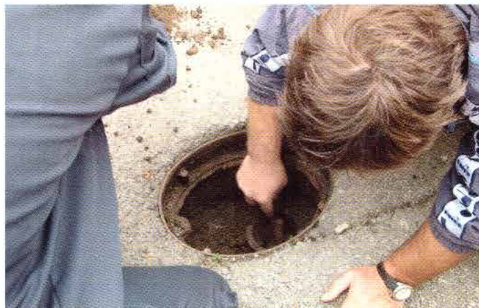
2005: Čiščenje talnih hidrantov na Lobčku.
