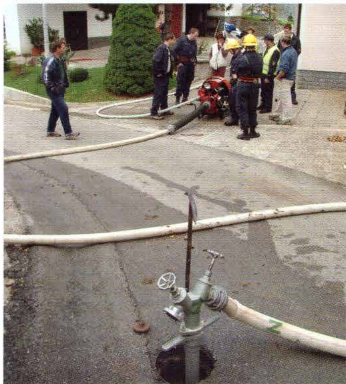
2005: Prikaz povečevanja pritiska iz hidrantnega omrežja z motorno brizgalno krajanom Lobčka.
