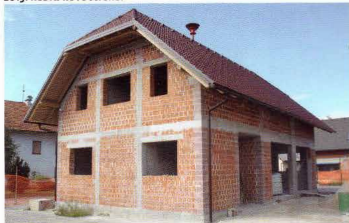
2013: Gasilski dom je že pod streho.
