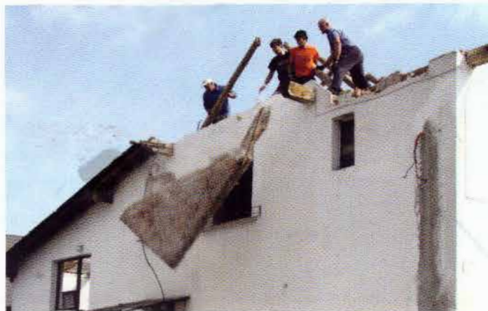
2012: Ko so dobili vse potrebne papirje in dovoljenja, so začeli podirati stari gasilski dom. 22. 10. 2012 je bil položen temeljni kamen.
