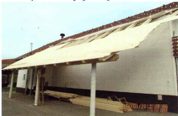
2012: Gradnja nadstreška ob gasilskem domu.
