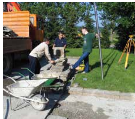
Pri polaganju tlakovnih plošč in drugih zunanjih površin so si pomagali tudi z nivelirjem, da so bile višine zaradi odtekanja vode čim boljše.
