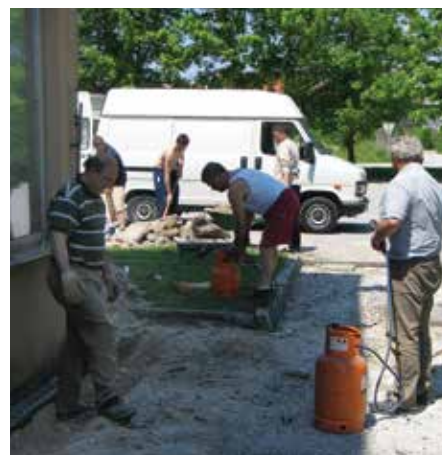
Člani obnavljajo asfaltno površino pred glavnim vhodom.
