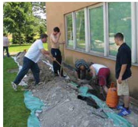
Sanacija izolacije na severni steni.
