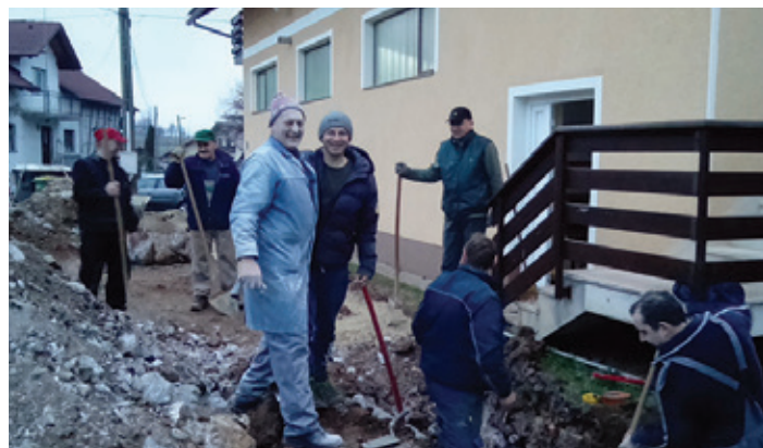
Izgradnja kanalizacijskega in vodovodnega priključka – marec 2016.
