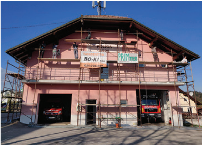
Barvanje opaža in fasade gasilskega doma, 23. 4. 2021.
