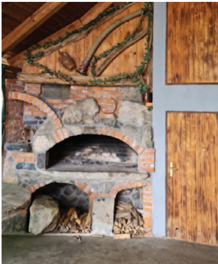
Izdelava kamina in nadstreška za gasilskim domom Luče 2022.
