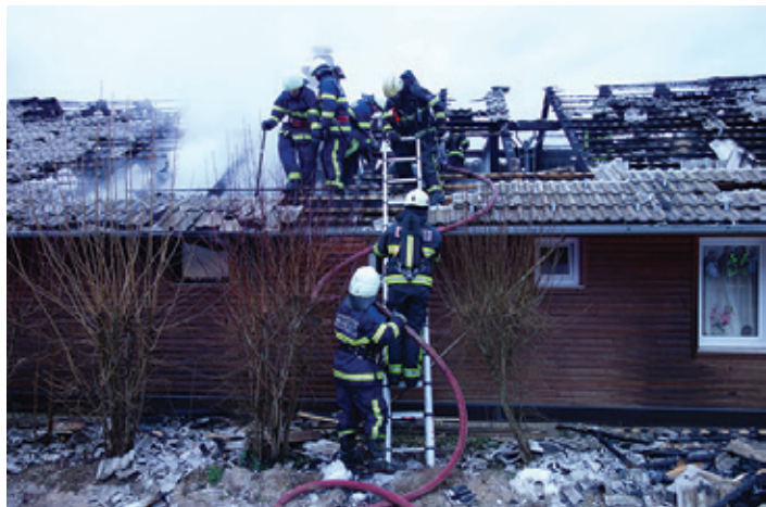
Požar hiše - Vrh pri Višnji Gori, 25. 2. 2015.
