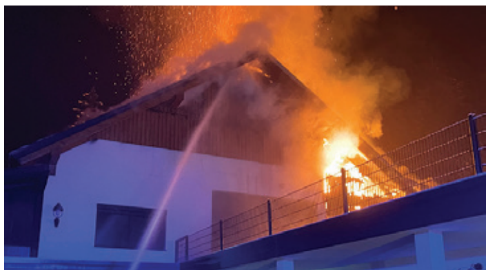
Požar gospodarskega objekta na Cerovem, 2. 3. 2023.
