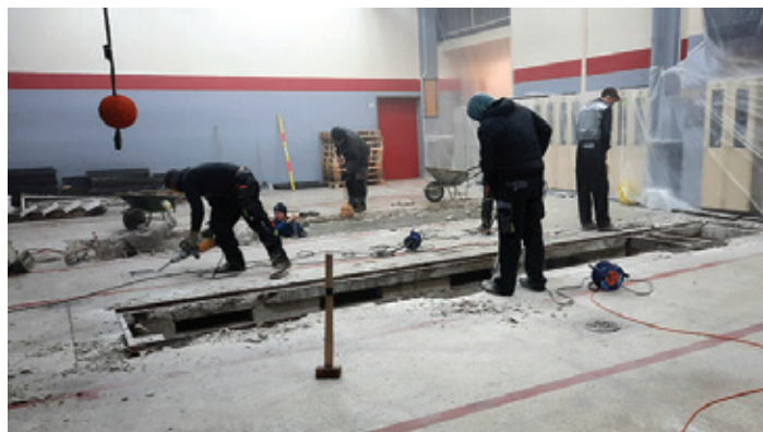
V decembru 2021 smo pričeli s celovito prenovo garažnih prostorov gasilskega centra.
