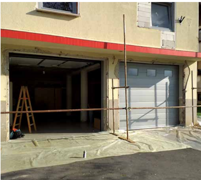
Menjava garažnih vrat na gasilskem domu in postavljanje odrov za izdelavo fasade septembra 2019.
