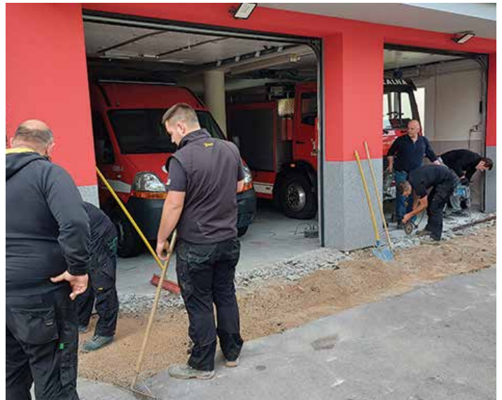
Ureditev pragov pri garažnih vratih in popravilo asfalta na uvozu v maju 2022.
