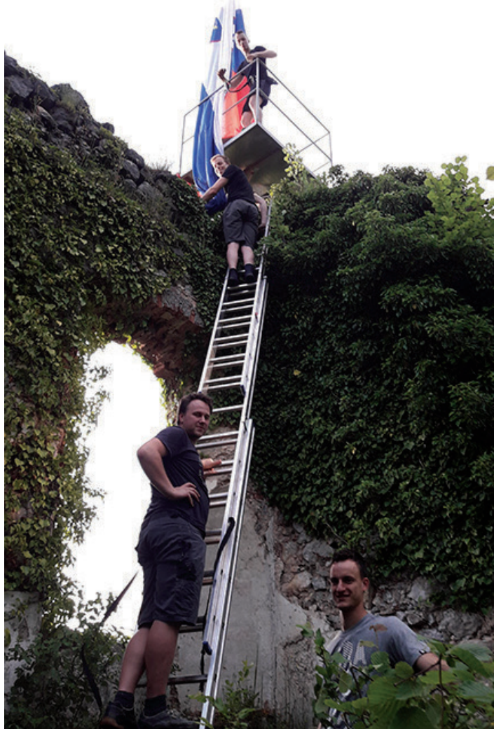
Menjava slovenske zastave na razvalinah gradu Boštanj so v letih 2018 in (zaradi poškodb v viharju) 2019 opravili zagraški gasilci.
