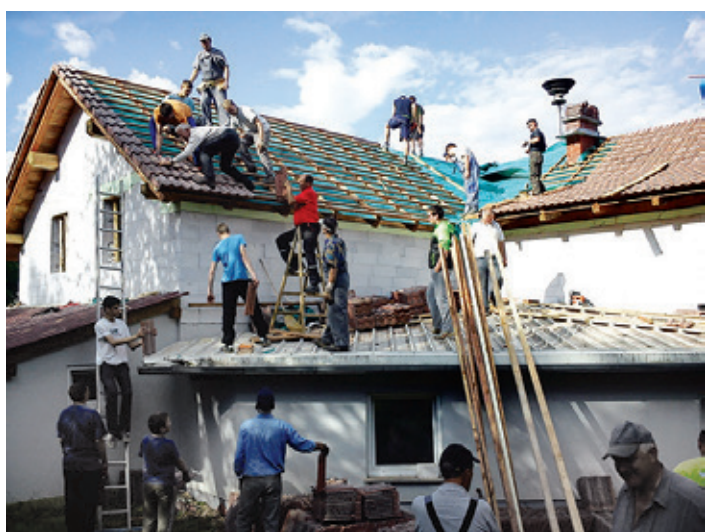
2015: Pokrivanje strehe pri nadgradnji gasilskega doma.
