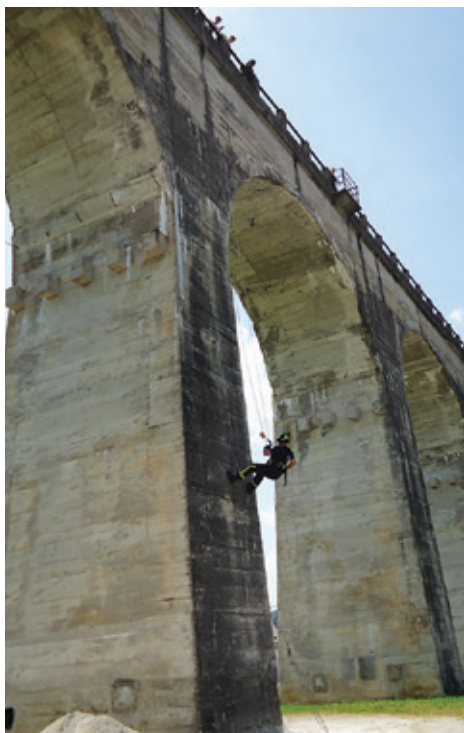
2015: Vaja vrhne tehnike, izvedena na viaduktu Velika Loka.
