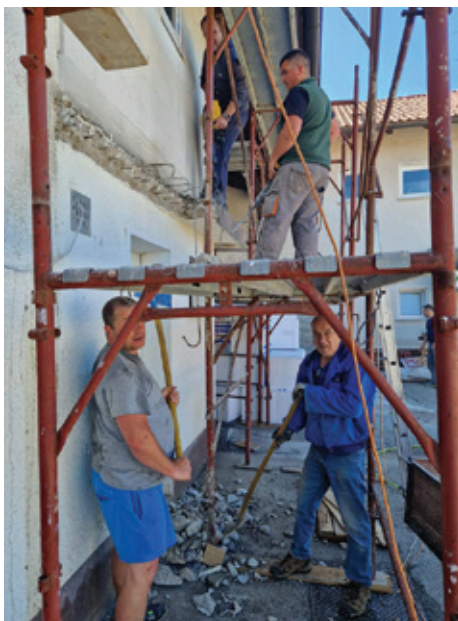
Obnova fasade in opažev na gasilskem domu v letu 2024.
