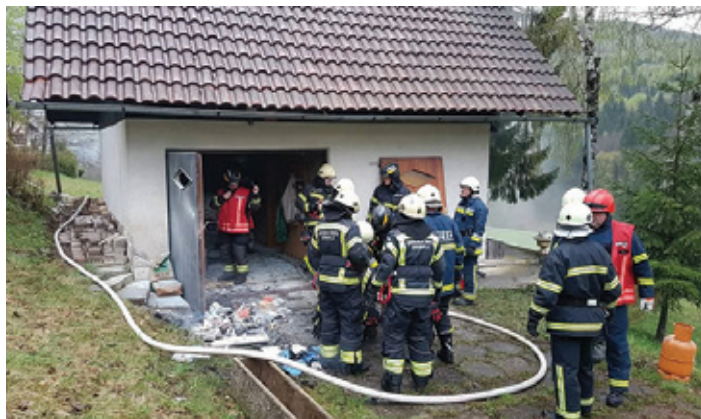
16. 4. 2018, intervencija Predole - požar v razdelilni elektro omarici.
