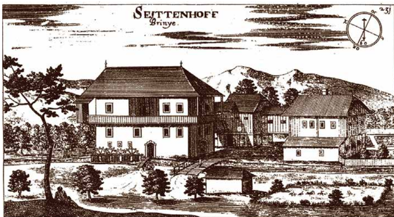
SLIKA ZGORAJ: Brinjski mlin v Valvasorjevem času (1669). Gradič zraven so pozidali pozneje.
