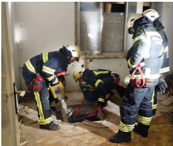
Vaja GZ Grosuplje NEURJE 6. 11. 2015. Gasilci na eni od točk so delali preboj preko betonske plošče za iznos ponesrečenca.
