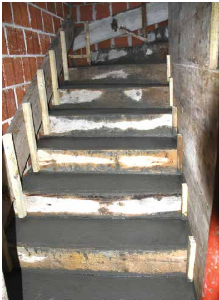
2012: Z betonom zalite stopnice
