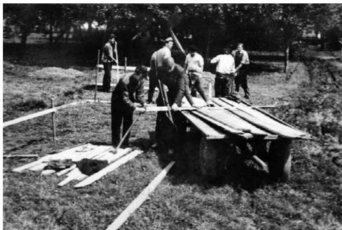
Zakoličbo in postavljanje gradbenih profilov za kopanje temeljev so člani naredili sami.
