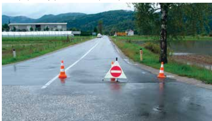
2010 – Poplave: Cesta proti Račni je bila poplavljenjena pri križišču za Malo Mlačevo.
