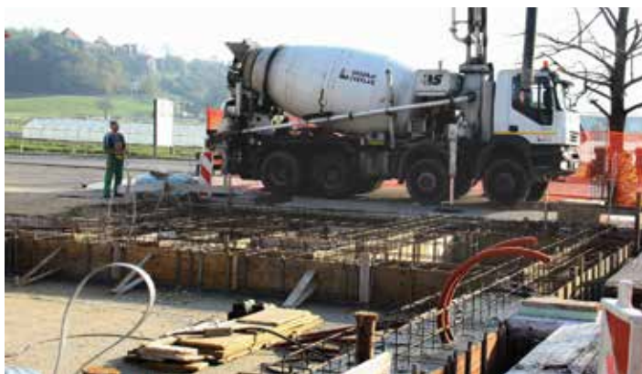
2012: Betoniranje temeljev
