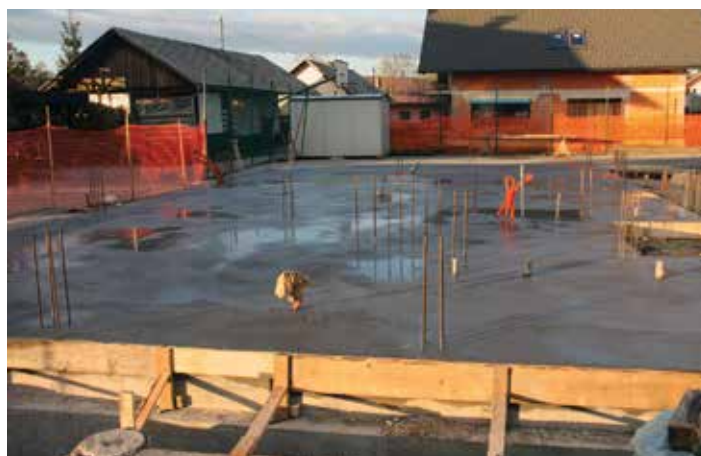
2012: Sveže zabetonirana temeljna plošča
