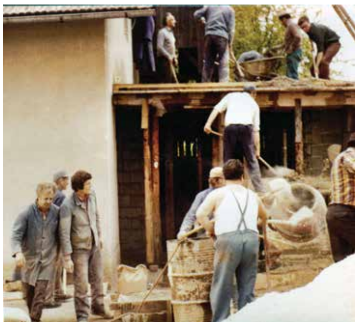
Utrinek ob betoniranju betonske plošče na prizidku garaže, leta 1977
