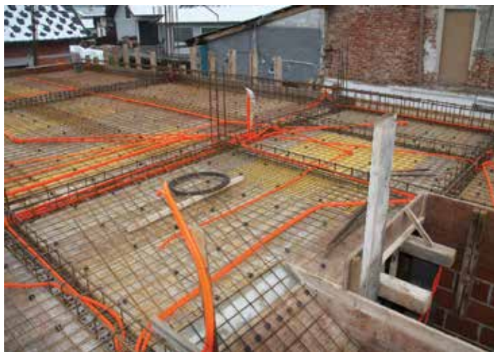
2012: Cevi na opaženi plošči, v katere bodo pozneje električarji položili kable
