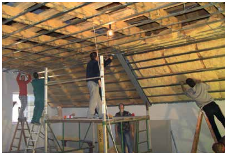
2013: Polaganje kovinskih profilov za knauf in termoizolacije v dvorani
