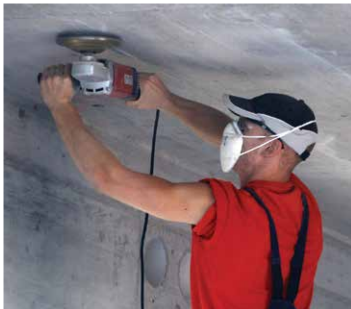
2013: Zahtevno brušenje betona s kotno brusilko pred končnim pleskanjem
