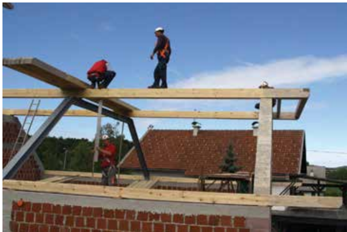
2013: Postavljanje osnovne strešne konstrukcije
