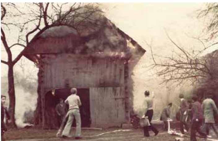
1977: Požar Zakrajškovega kozolca
