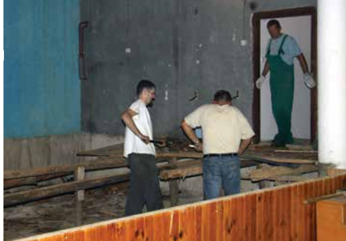
2012: Demontaža lesenega odra
