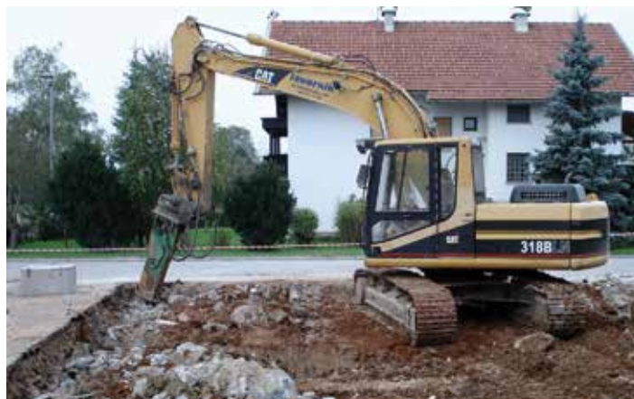
2012: Stare temelje je bilo treba pikirati z bagrom.
