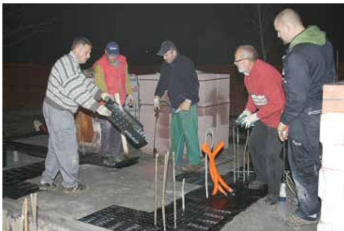
2012: Polaganje hidroizolacije so opravili člani društva pozno v noči.
