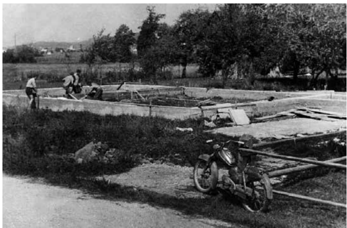
Razopaževanje zabetoniranih temeljev.
