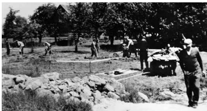
Gradnjo temeljev gasilskega doma po spremenjenem načrtu so začeli šele leta 1962.
