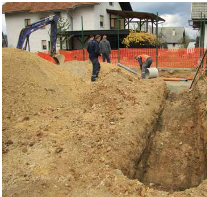
2013: Polaganje meteornih kanalizacij
