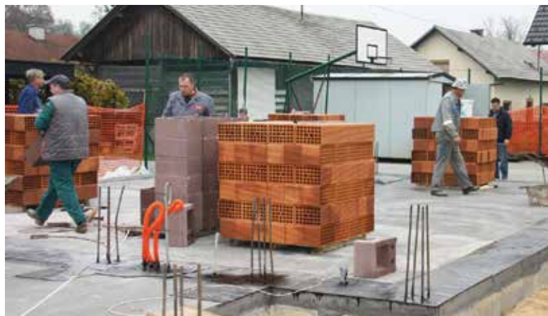
2012: Prav tako so člani pod kontrolo izvajalca gradbenih del pozidali celo etažo z opečnimi modularnimi kvadri.
