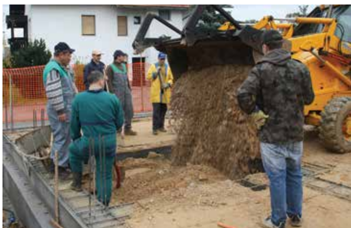
2012: Za nasipanje gramoza so si pomagali s strojem.
