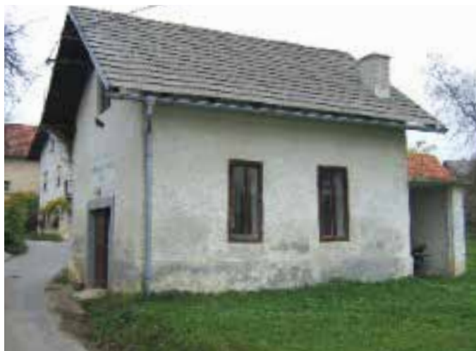
Po izgradnji prizidka za prevozno ročno brizgalno so malomlačevski gasilci kmalu naleteli na nerešljiv problem dostopa do te garaže.
