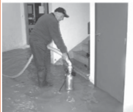
S potopno črpalko na hodniku gasilskega centra.
