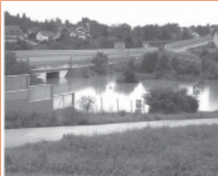
V nedeljo je bil ob 10.13 žmarski avtocestni priključek približno 2,5 m pod vodo.
