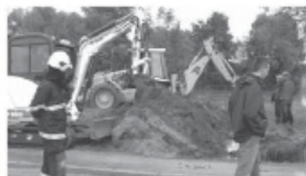
Nekoč je bil poleg mostu ob Bregu pri Velikem Mlačevem še večji propust Ø80, ki je skrbel, da se je razlita voda v depresiji za strugo potoka prelivala naprej pod cesto proti Radenskomu polju. Ob gradnji pločnika in sočasne gradnje vzdolžne kanalizacije za odvodnjavanje ceste na tem mestu ter poznejšega zasipavanja bližnje parcele, je bil propust zasut in ni omogočal pretoka vode od novozgrajenih hiš in dostopne ceste. Nedvomno bi bile poplave v bližnjih šestih stanovanjskih hišah, če bi propust ne bil zasut, precej manjše (19. 9., ob 11.04).
